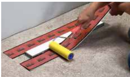
Шаг 3 – Наклеивание гидроизоляционной манжеты Seal System
