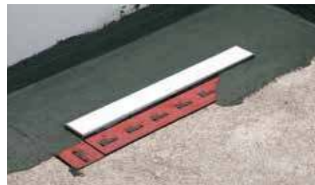
Шаг 4 – Нанесение гидроизоляционного слоя
