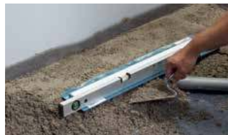
Шаг 2 – Укладка бетонной стяжки
